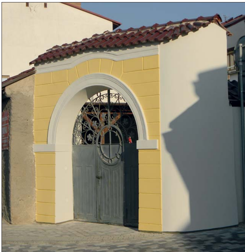
Brána domu čp. 14 po obnově v roce 2015 (k článku P. Slavíka)
