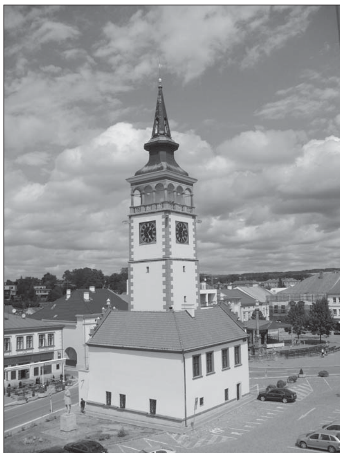
Budova radnice v roce 2008
